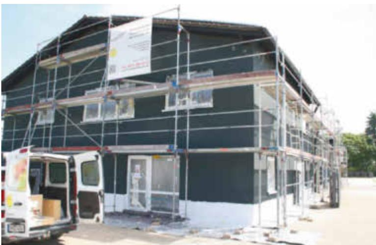
Die Fassade nach dem ersten Anstrich: Die Dachunterseite wurde bereits mit „Sigma Wetterschutz-Farbe“ in RAL 9005 Tiefschwarz gestrichen.
