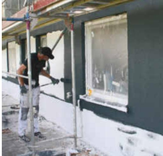
Die Fassadenfarbe „Sigma Siloxan All Season Ultra Cool“ ist eine hochwertige Silikonharzfarbe, die in sehr dunklen Tönen wie Anthrazit RAL 7016 werkseitig durch Zugabe einer speziellen Paste mit TSR-Technologie (Total Solar Reflectance) getönt werden kann.
